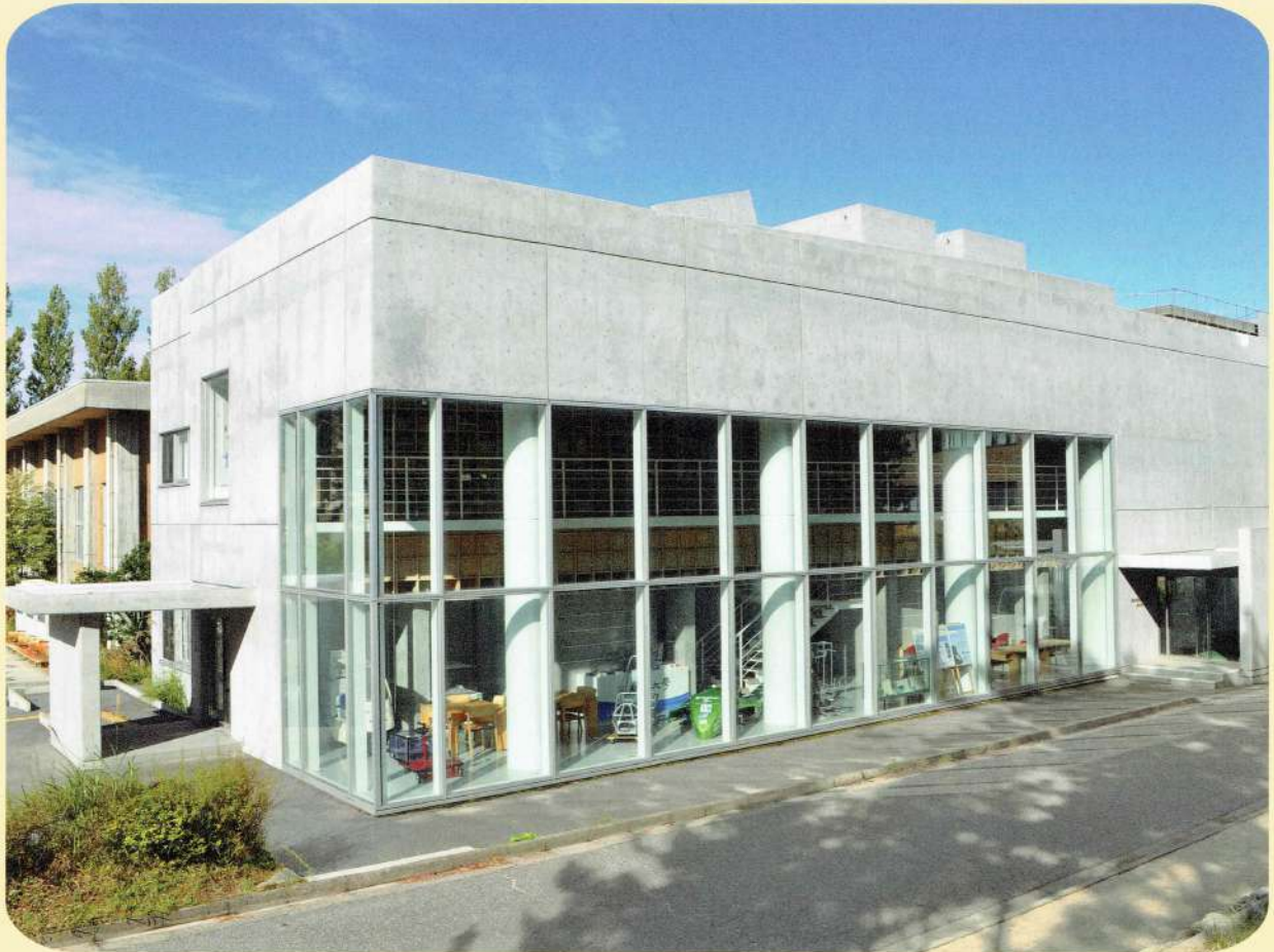
新潟大学科学技術交流悠久会館
