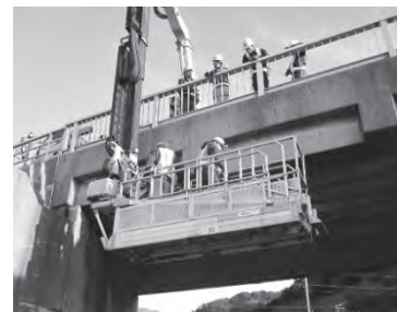
橋梁点検車による点検の様子
