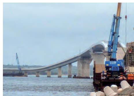
建設中の伊良部大橋
