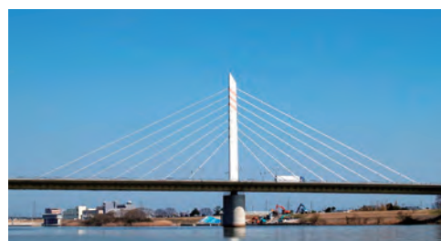
ときめき橋（新潟市西区～中央区）
