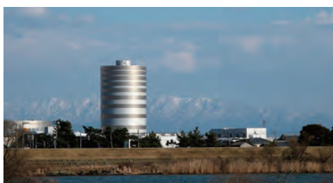
信濃川浄水場（新潟市江南区）
