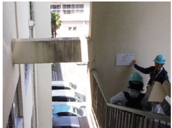
2016年熊本地震の被害調査
