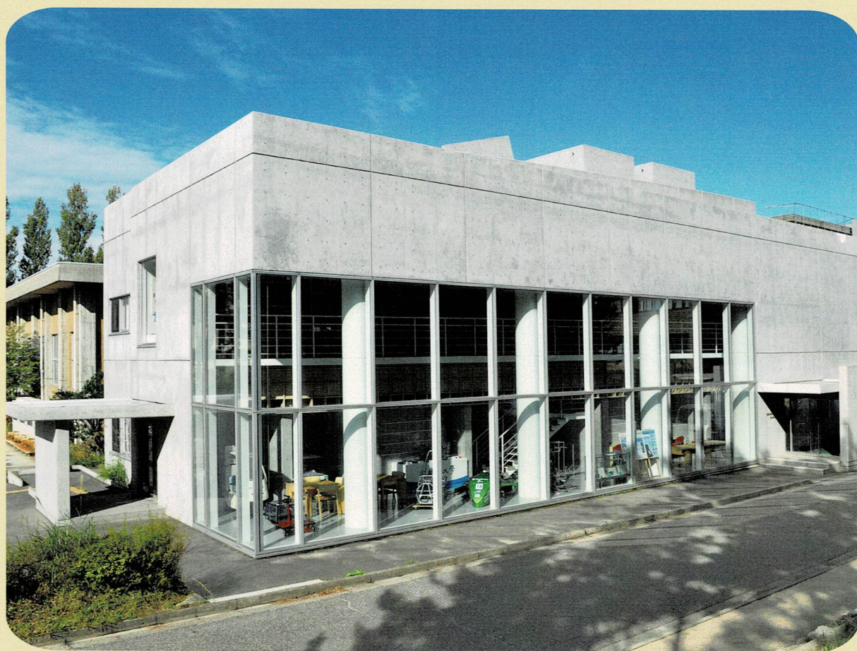
新潟大学科学技術交流「悠久会館」
