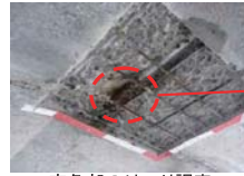
変色部のはつり調査
