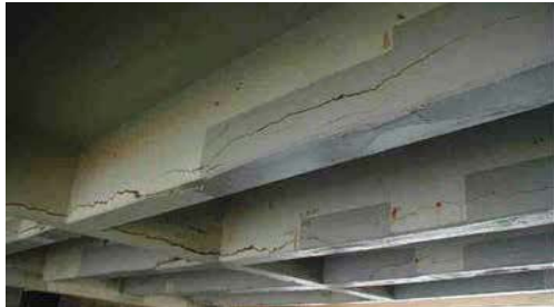
塩害による断面修復箇所：修復箇所やその外側でひび割れ・うき
