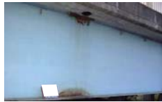
排水装置直下の腐食
