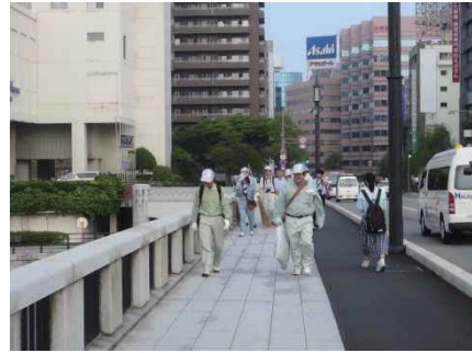
萬代橋 橋面・高欄の点検作業
