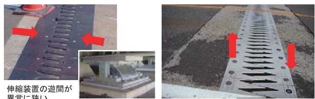
伸縮装置の遊間が左右(橋軸直角方向)で不均等
