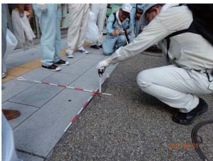
歩道破損箇所の損傷測定作業
