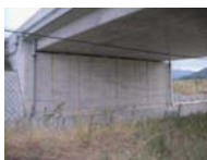
コンクリート内部
