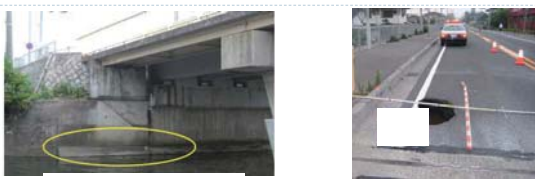
過去に橋台背面で路面陥没
