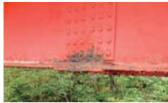
高力ボルト連結部の腐食
