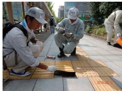
点字ブロックの補修作業
