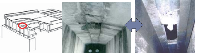
PCT桁の間詰め部での漏水 間詰めコンクリートの抜け落ち
