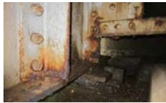
桁端部の腐食 下フランジ部が特に進行している
