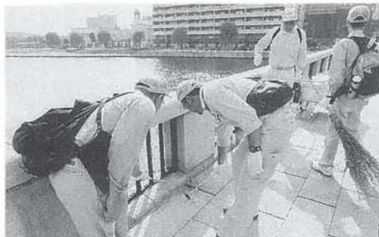
参加者による萬代橋の点検・清掃
