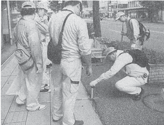
歩道にできた亀裂を計測するME新潟技術者
