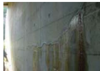
コンクリート内部における鉄筋腐食が疑われる事例
