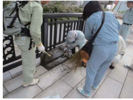
歩道板のがたつきの補修作業
