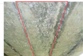
G3桁NO.2(劣化桁) 損傷写真-1
