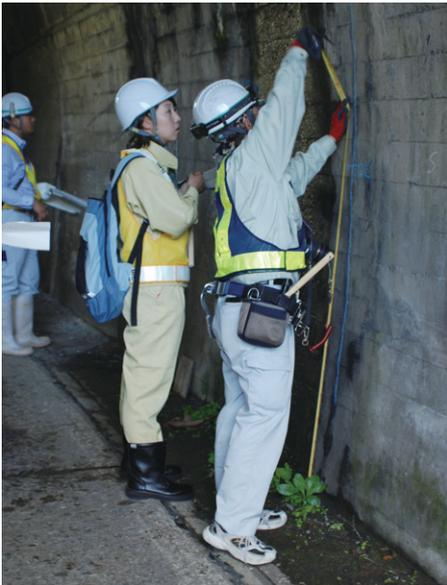
揚川トンネルにて。前回点検時からのひびの延伸量を確認 (H26.9.26)
